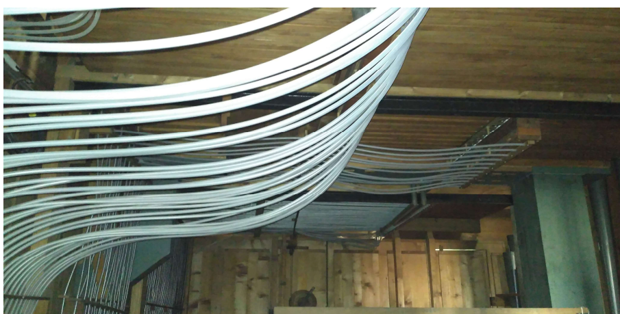
Obrázek 9 Pneumatická traktura, kostel sv. Mikuláše
